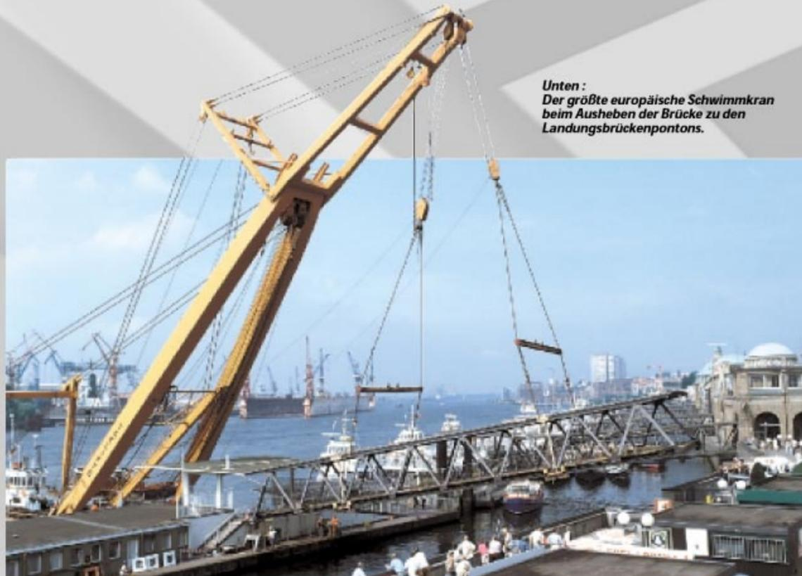
Unten: Der größte europäische Schwimmkran beim Ausheben der Brücke zu den Landungsbrückenpontons.
